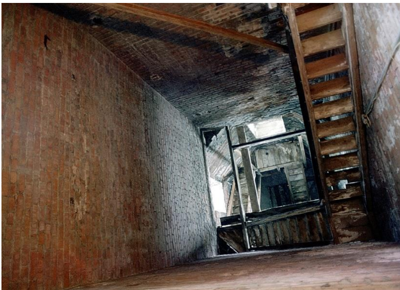
22. 23. Vue de l'intérieur de la tour de l'église Saint-Cœur-de-Marie : une structure de maçonnerie (© Luc Noppen, 2005).
