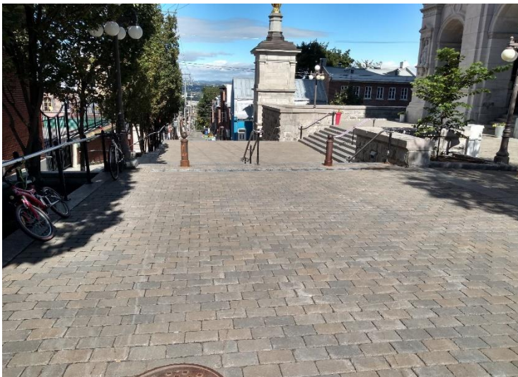
▼ Parvis et escaliers réaménagés en 2001 (© Pierre Fraser, 2021)
